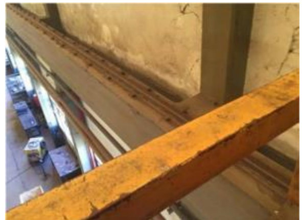
Fotografía N° 20 – Vista Superior Viga Carril
