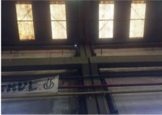
Fotografía N° 11 – Viga Carril y Columnas
