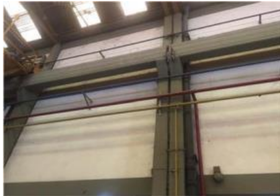
Fotografía N° 9 – Viga Carril y Columnas
