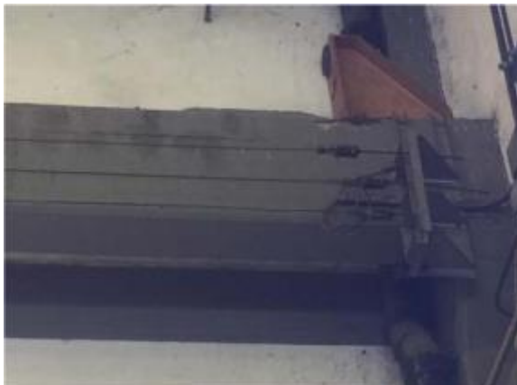
Fotografía N° 19 – Vista Lateral Viga Carril
