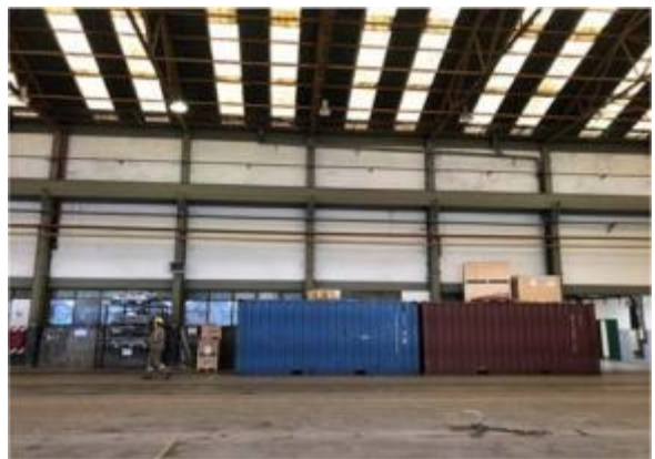
Fotografía N° 8 – Viga Carril y Columnas
