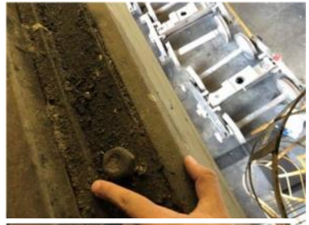
Fotografía N° 18 – Unión Riel con Viga
