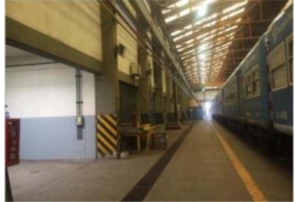
Fotografía N° 6 – Pared Lateral Interior
