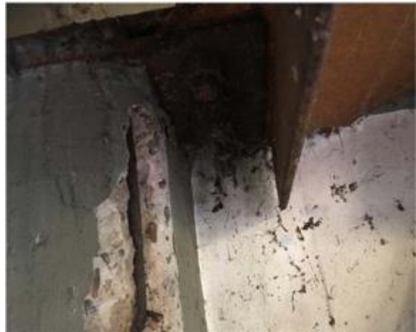
Fotografía N° 30 – Armadura Expuesta
