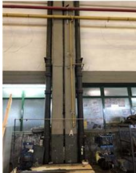
Fotografía N° 14 –Columnas (Junta constructiva)
