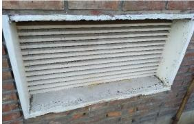
Se retirará el oxido superficial de las carpinterías mediante su rasquetado con cepillo de alambre, lijas tipo esmeril o medios mecánicos. Se aplicará convertidor de oxido y se repararán las superficies afectadas con masilla plástica de dos componentes.
