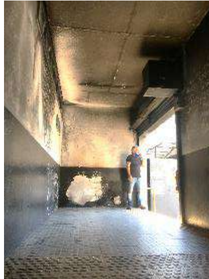
Imagen 12 – Referencia Acceso al Pasillo Peatonal bajo nivel de la Est. Ciudadela
