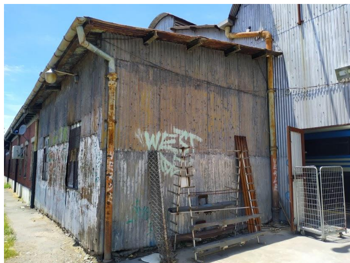
Imagen 14 – Bajadas pluviales exteriores del taller.
