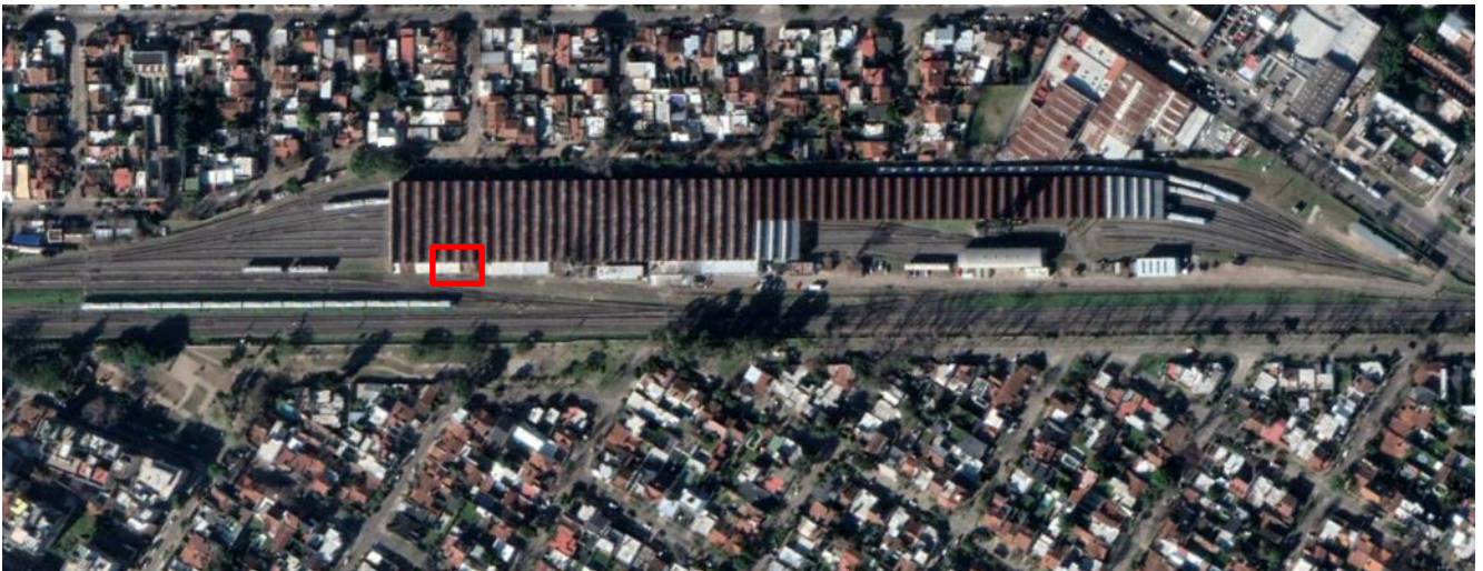
Imagen N°1 – Vista área del emplazamiento del TALLER CASTELAR (Trenes Argentinos)
