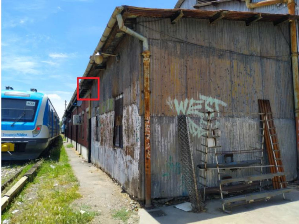
Imagen 9 – Bajadas pluviales existentes
