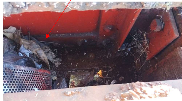
Vista sobre estructura
