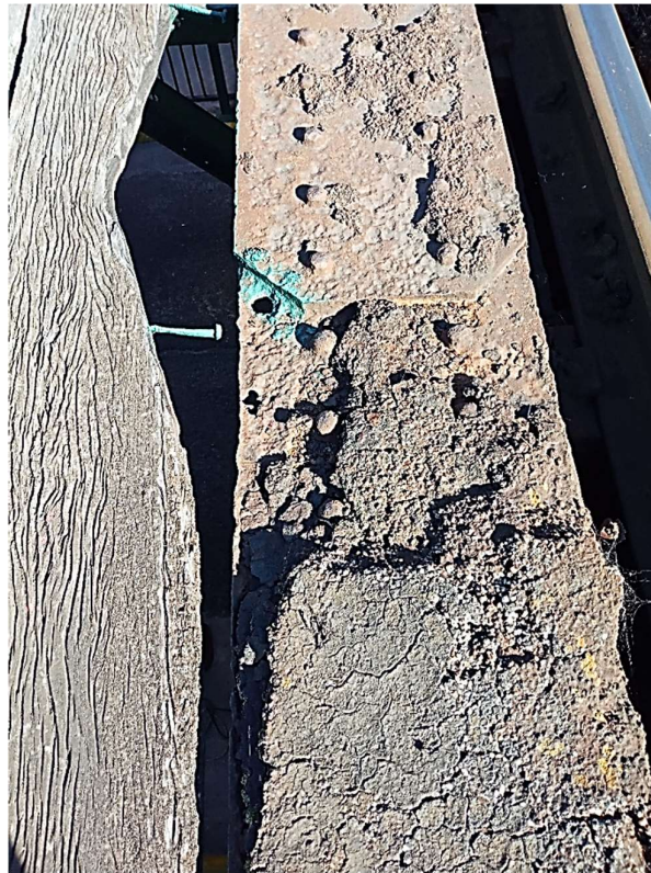
Vista sobre Vigas principales
