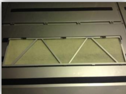
Imágenes de conjunto filtro de aire de retorno (marco porta filtro y elemento filtrante)
