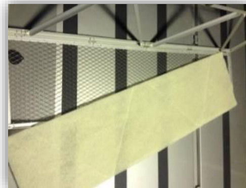
Imágenes de conjunto filtro de aire de retorno (marco porta filtro y elemento filtrante)
