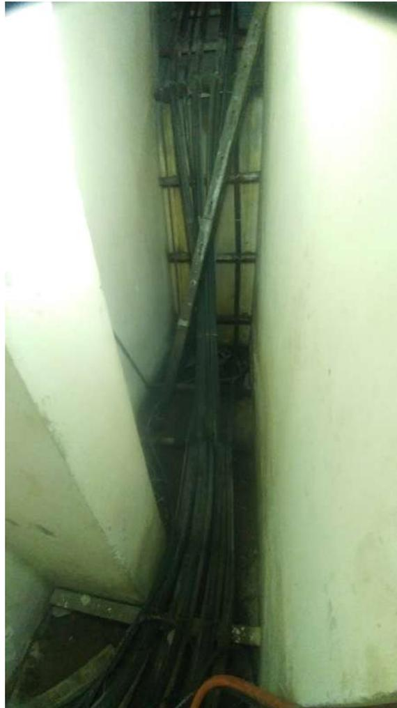
(Foto 5- Acometida Cable M.T desde Cámara Existente)
