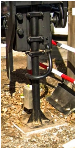
Imágenes de Referencia: Detalle de Anclajes en paso a nivel y detalle de armadura de varillas roscadas.
