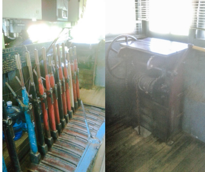
Imágenes de Referencia: Cabín 3 - San Martín, cuadro de palancas y torno manual bajada/subida de barreras.
