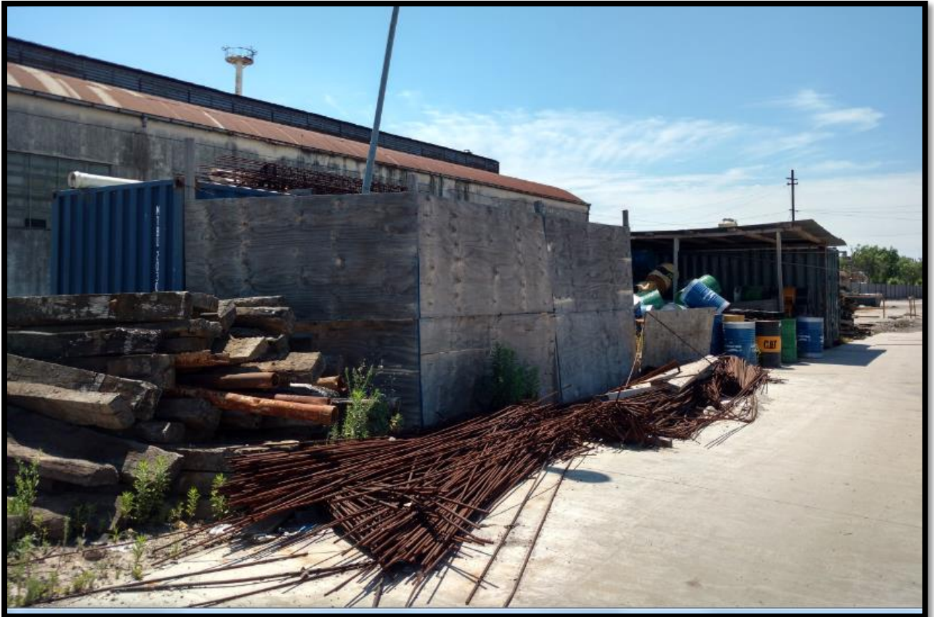
Ilustración 2. Módulos metálicos y elementos a reubicar
