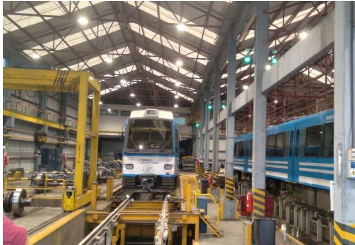
Lugar de instalación vía N°4
