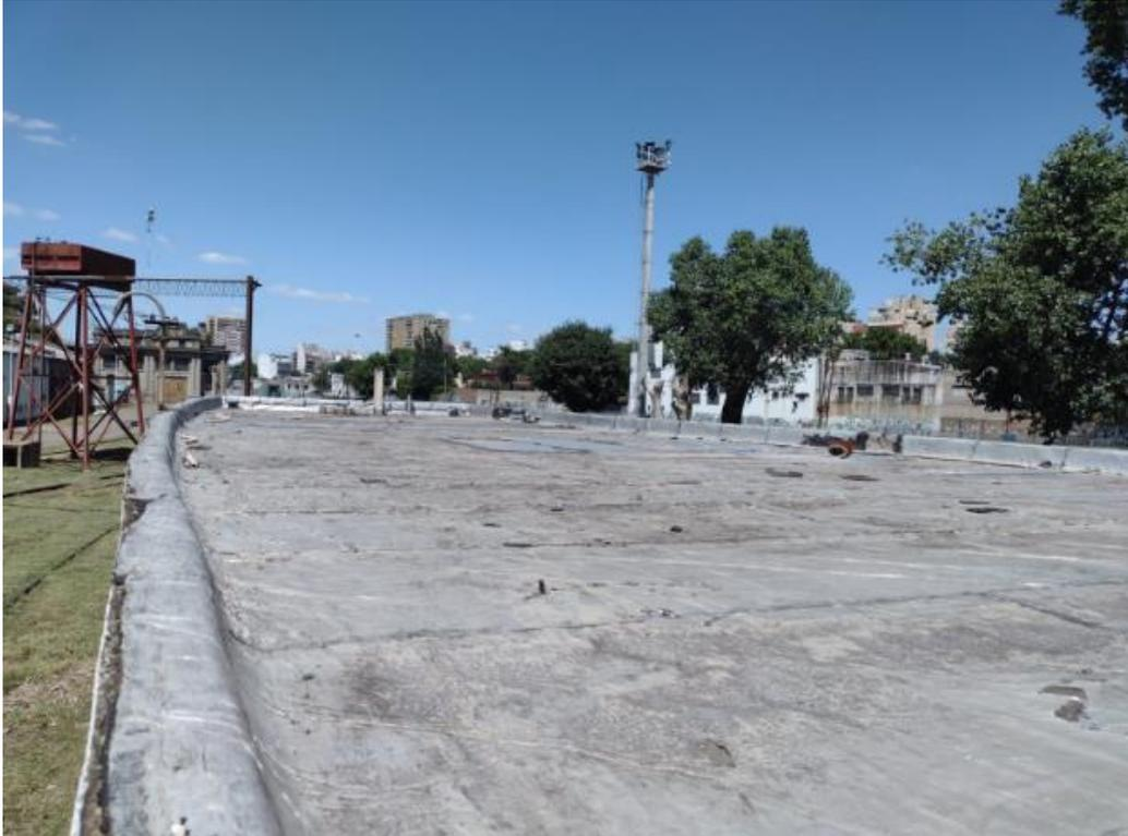
Imagen Nº 09: Vista del estado de la membrana existente (hacia el Este).
