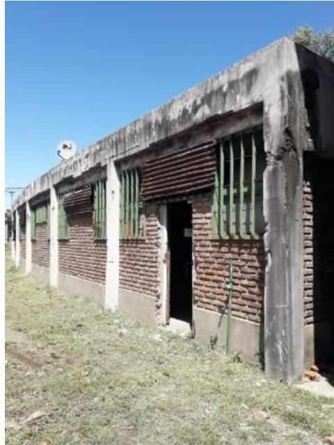
Imagen Nº 03: Exterior - retiro de puerta y completamiento muro similar características.
