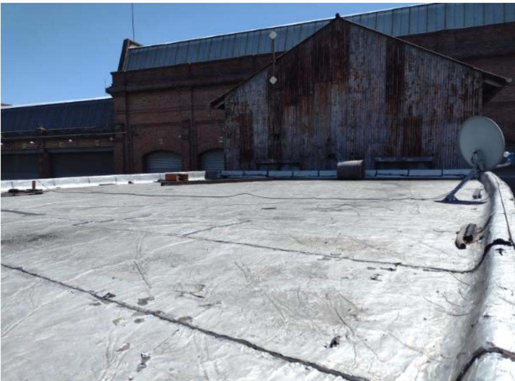
Imagen Nº 10: Vista del estado de la membrana existente (hacia el Oeste).
