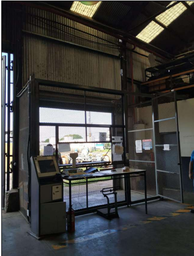
Puerta a adecuar.
