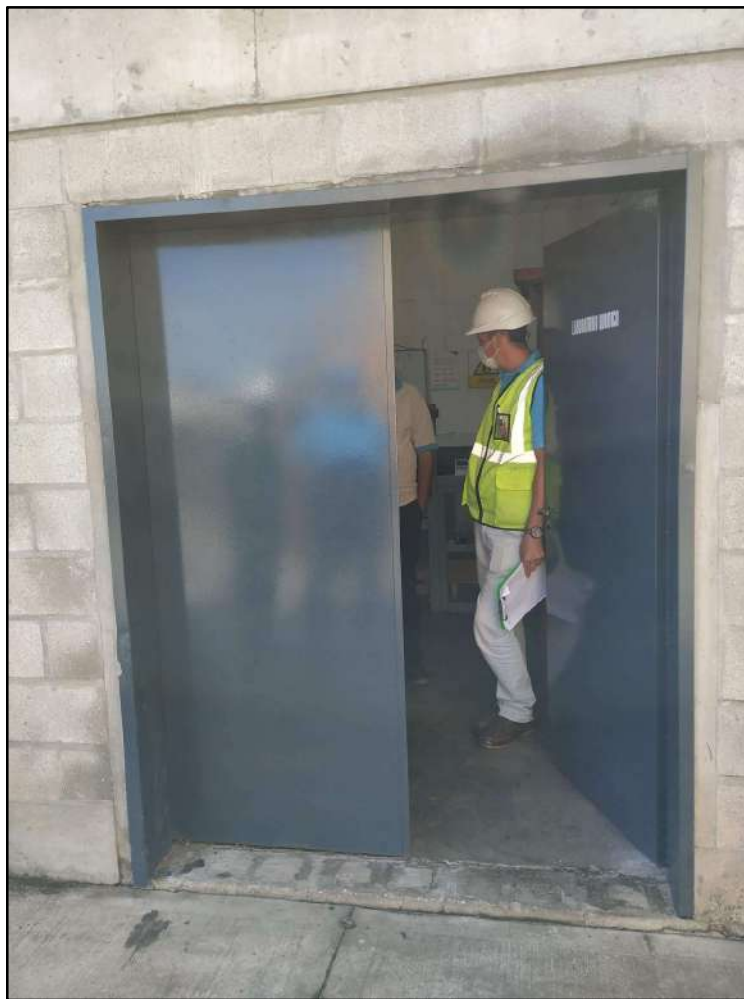
Puerta a adecuar.
