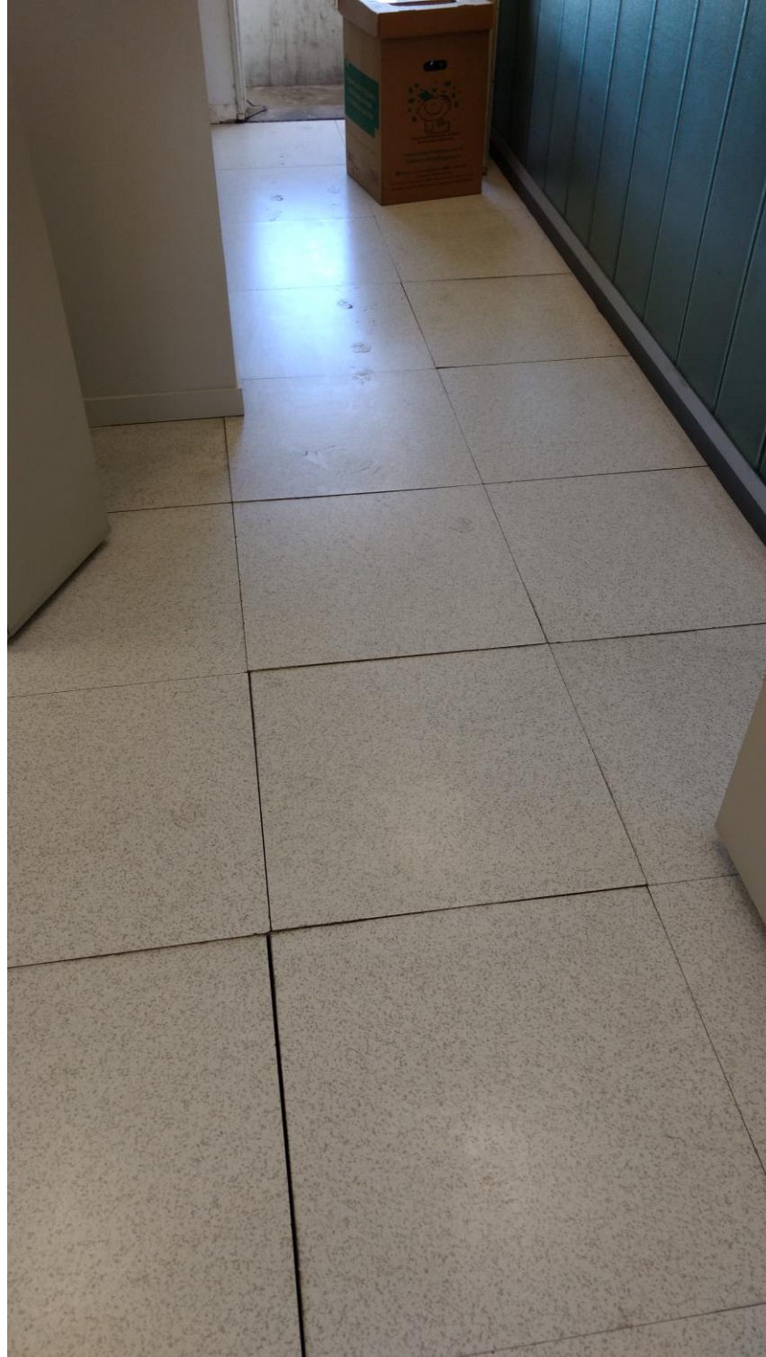
RELEVAMIENTO FOTOGRAFICO - REACONDICIONAMIENTO DE PISO TECNICO CABIN 1 PISO 7 - PCT - LINEA MITRE
