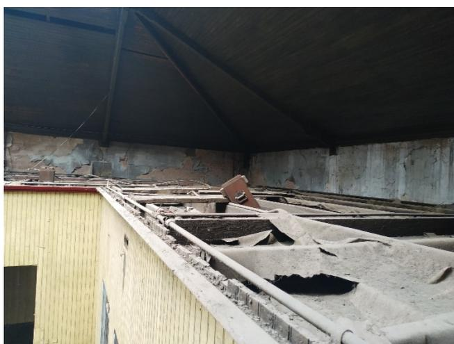
*Estructura de madera existente a mantener*
