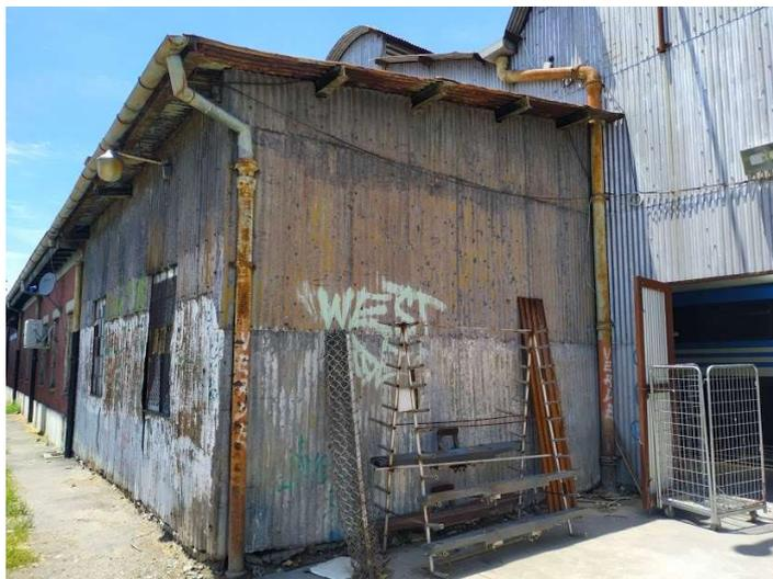
Imagen 14 – Bajadas pluviales exteriores del taller.
