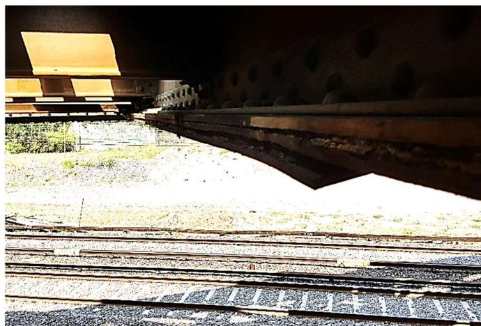
Formación de óxido entre platabandas y entre platabanda y ala inferior
