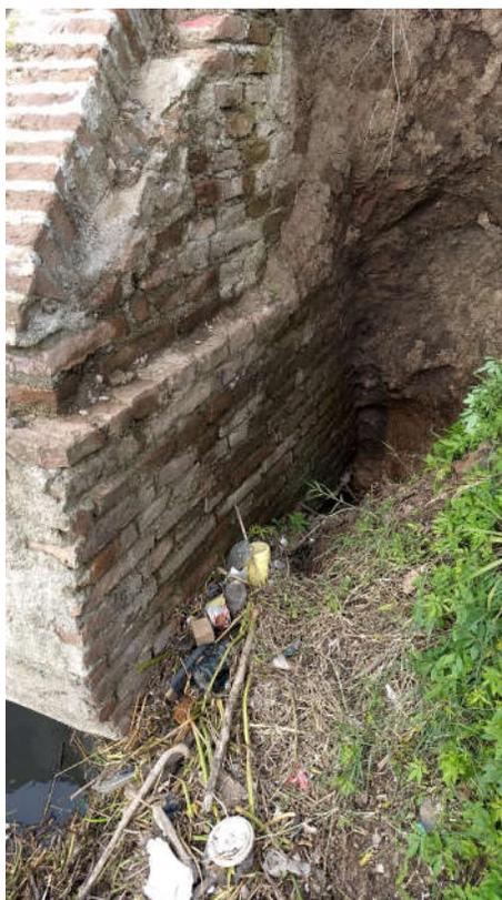
**Socavación y falta de sustentación en espaldas de muro ala.**
