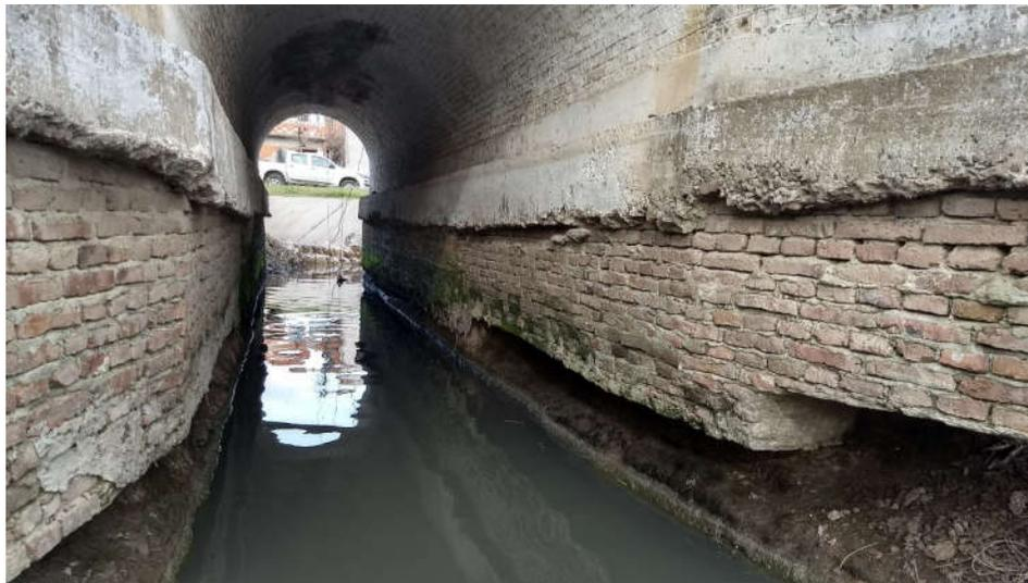
**Fundaciones expuestas y socavación parcial de apoyo en muros laterales.**
