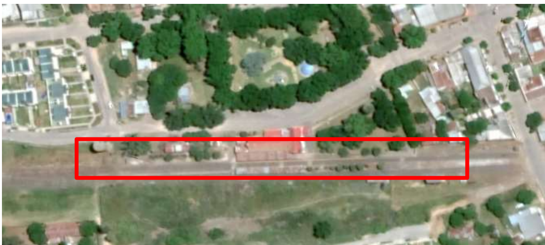
Imagen N°4 – vista área de le Estación Suipacha.
