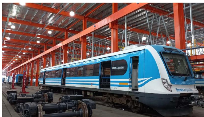
Vista de la vía de accidentales y las columnas para vincular los brazos metálicos
