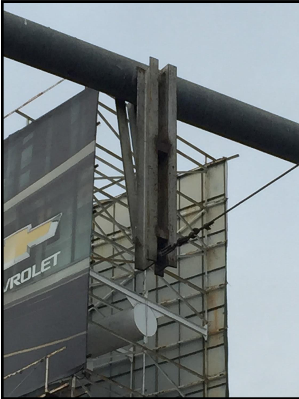
Ilustración 4. Soportes de línea de vida a reubicar
