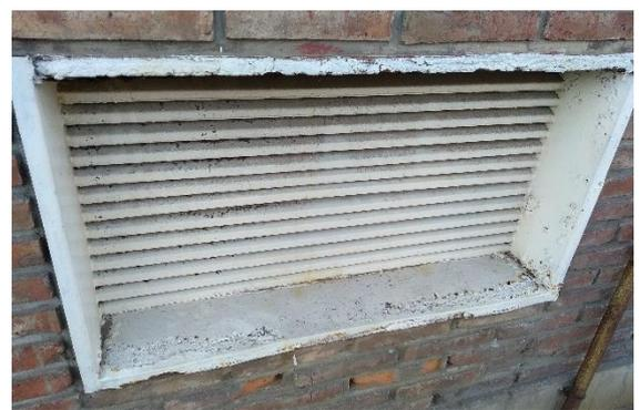
Se retirará el óxido superficial de las carpinterías mediante su rasquetado con cepillo de alambre, lijas tipo esmeril o medios mecánicos. Se aplicará convertidor de óxido y se repararán las superficies afectadas con masilla plástica de dos componentes.
