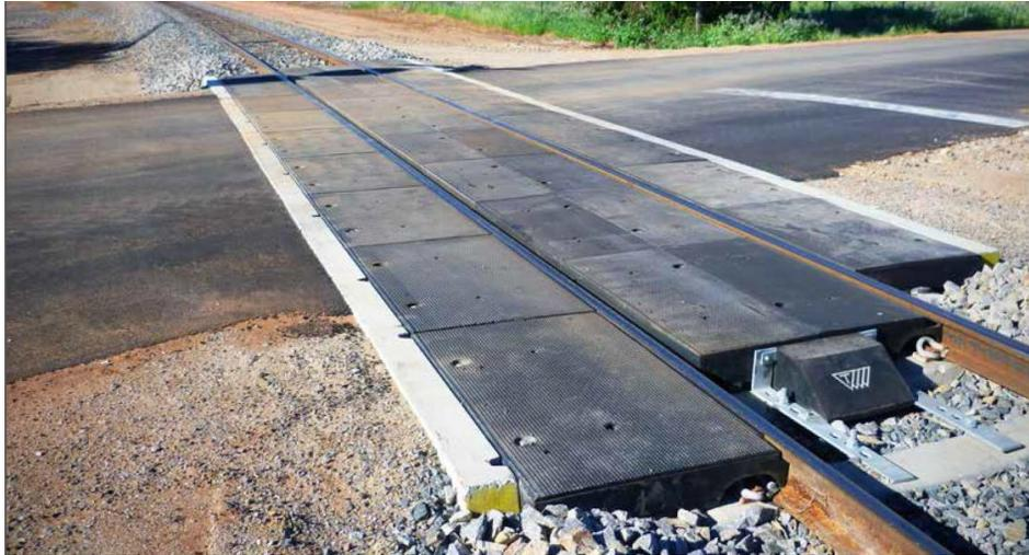
Debe tenerse en cuenta la diferencia de asiento de la placa para los dos casos existentes en la Argentina: Pasos a Nivel con Durmientes de Madera y Pasos a Nivel con Durmientes de Hormigón.
