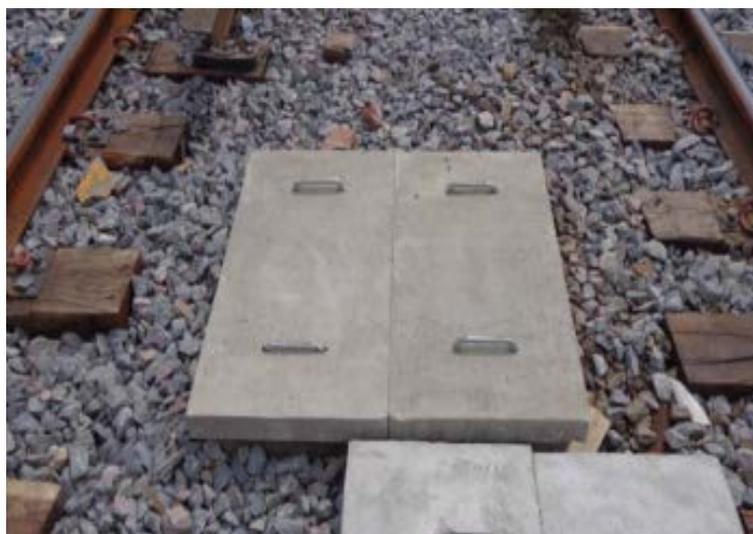
Imagen 6 - Tapa de cámara de inspección
