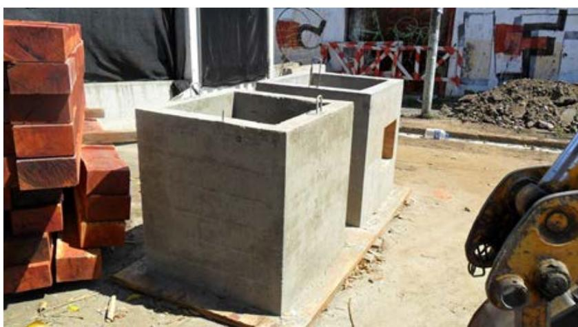
Imagen 5 – Cámara de inspección de referencia
