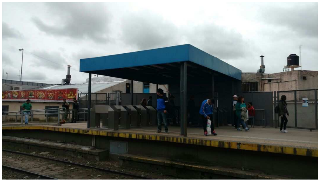
ANEXO FOTOGRAFICO - Cierres laterales de refugios en Estaciones Villa Crespo (descendente punta Pilar), San Miguel (descendente punta Pilar) y José C. Paz (descendente punta Pilar)
