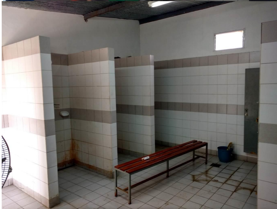
ANEXO FOTOGRAFICO - ADECUACIÓN DE DEPÓSITO PARA PERSONAL EN LAVADERO DE COCHES EN PREDIO RETIRO - LÍNEA SAN MARTIN
