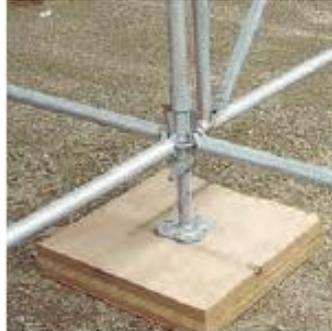
La plataforma de soporte directo de las personas estará conformada por placas de fenólico negro de 18 mm de 1.22 m x 2.44 m, sustentadas por soleras de caño estructural cuadrado de 40 mm x 80 mm y travesaños de tubos de sección circular de  $\varnothing$  38 mm., deberán contar con barandas reglamentarias (respetar alturas necesarias y/o convenientes para el tránsito seguro).
