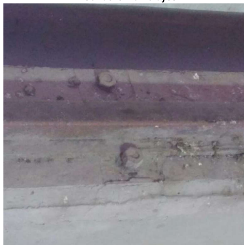
Fisuras en anclajes
