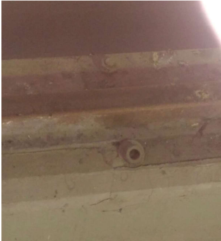
Fisuras en anclajes
