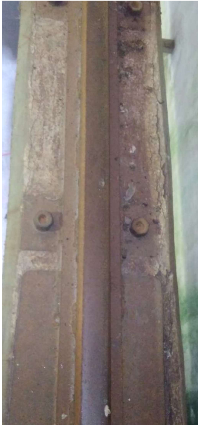
Vista superior riel y anclajes
