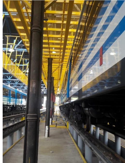
Bajo Pasarela de Fosa 6-7
