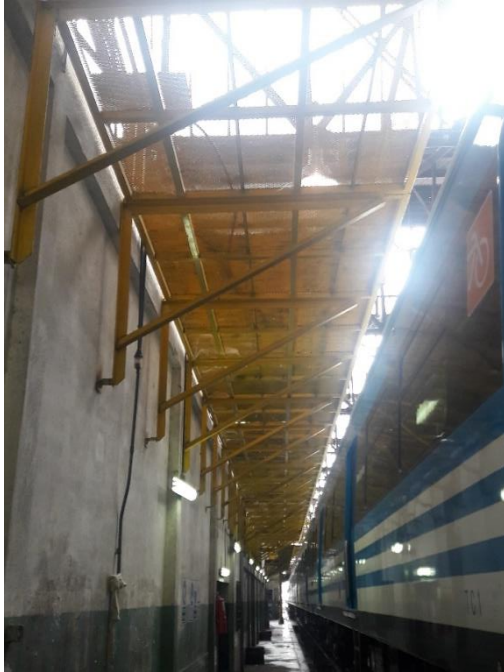
Bajo Pasarela de Fosa 1
