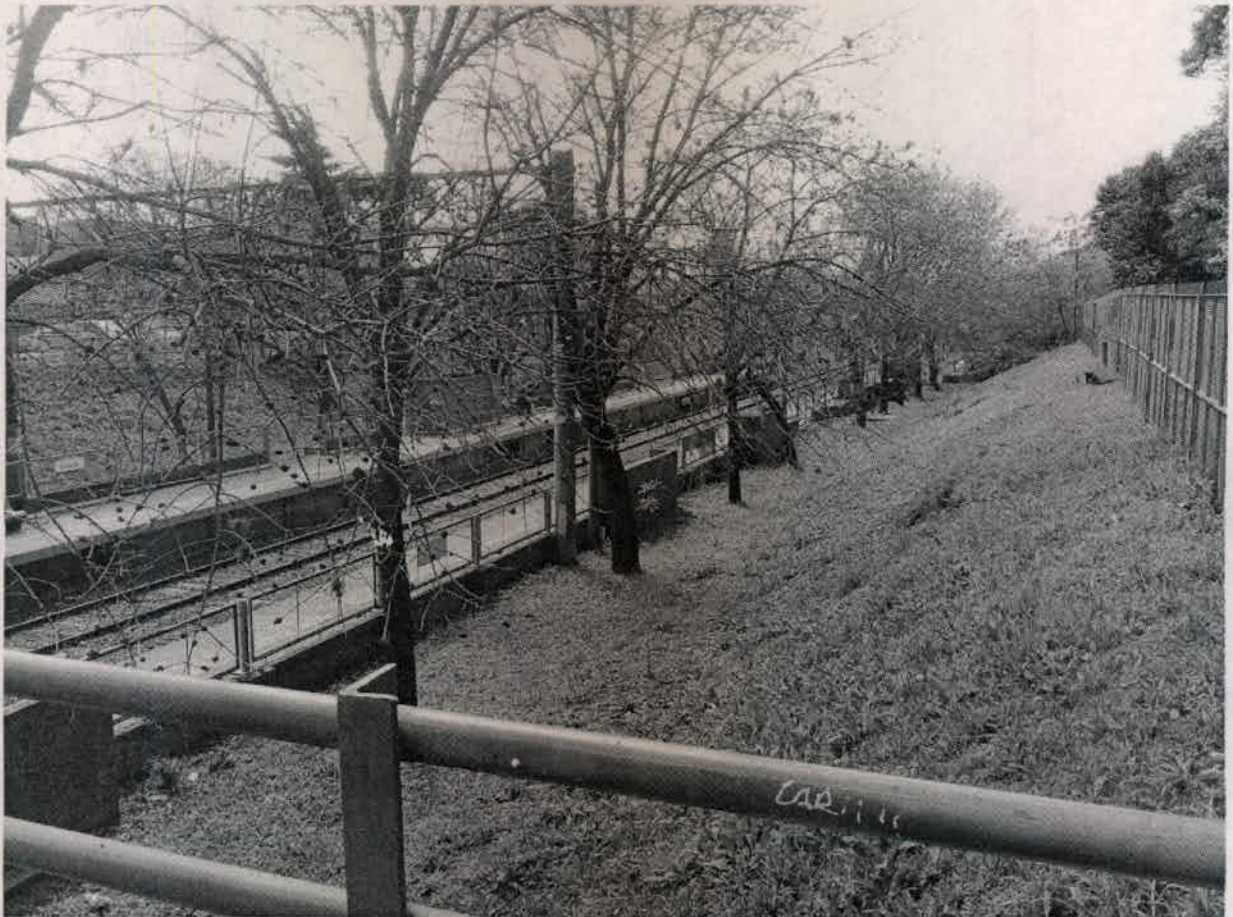
Fotografía 2 Andenes en trinchera de la estación Turdera.
