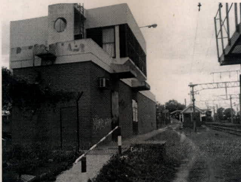
VISTA DEL EDIFICIO
