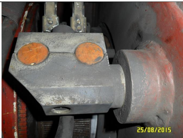
Figura N° 1 - soldadura en el lado interior del motor
