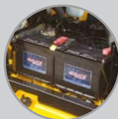
Instalación de pila rotatoria
