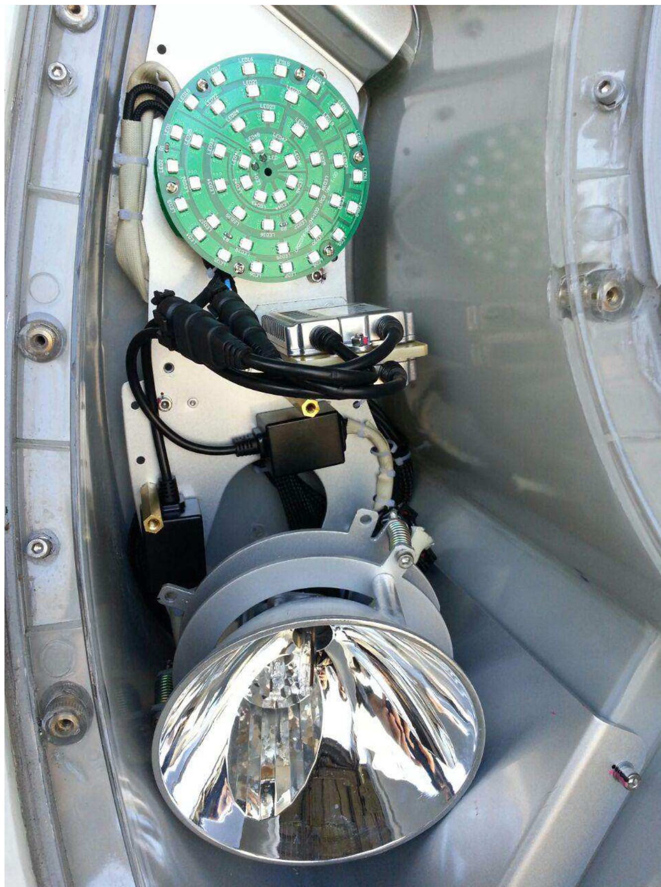
2.5. Cables con protección térmica en funda de fibra de vidrio
