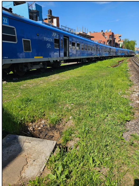
Cámara existente (punta Torno Bajo Piso), sector a zanjear para renovación con nuevo desagüe entubado
