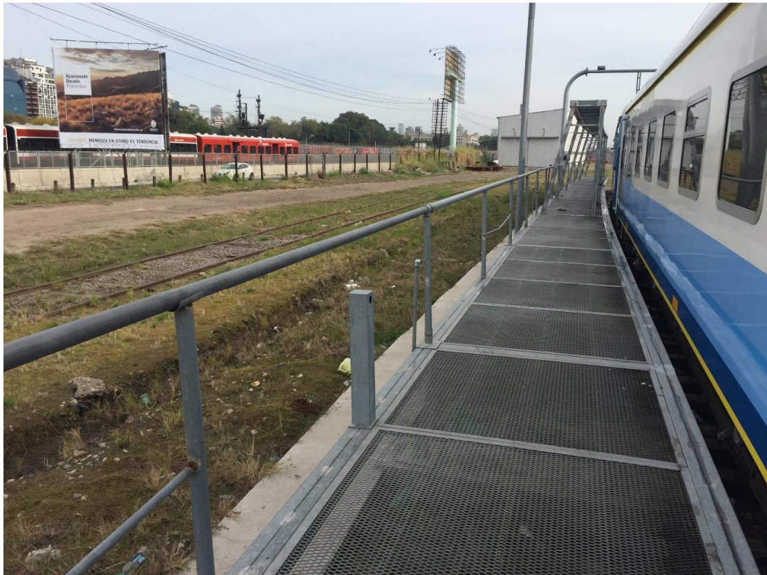
PLATAFORMA 1 – BARANDAS DE SEGURIDAD
