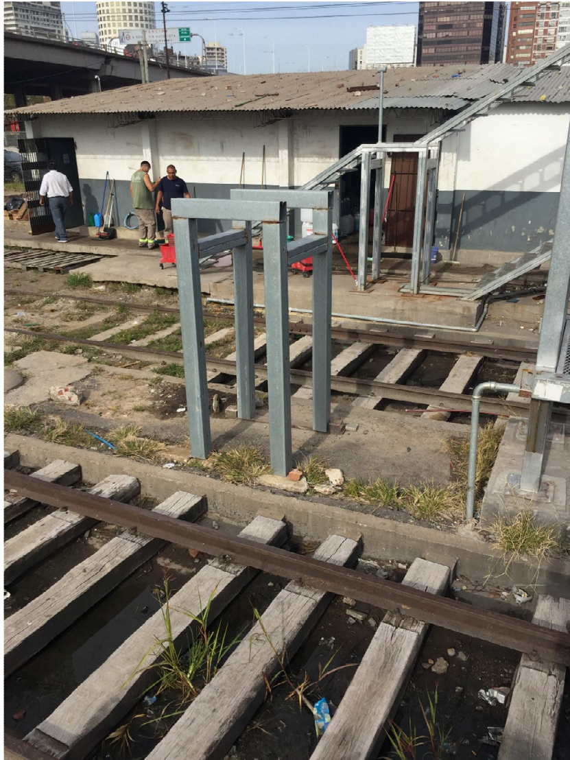
LADO RETIRO – SECTOR ESCALERAS
