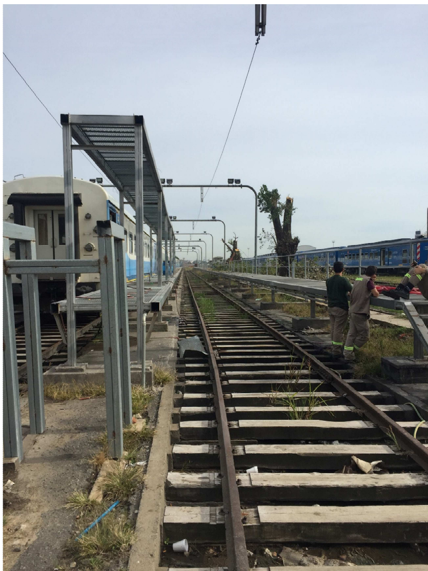
PLATAFORMAS 2 Y 3 – LADO RETIRO
