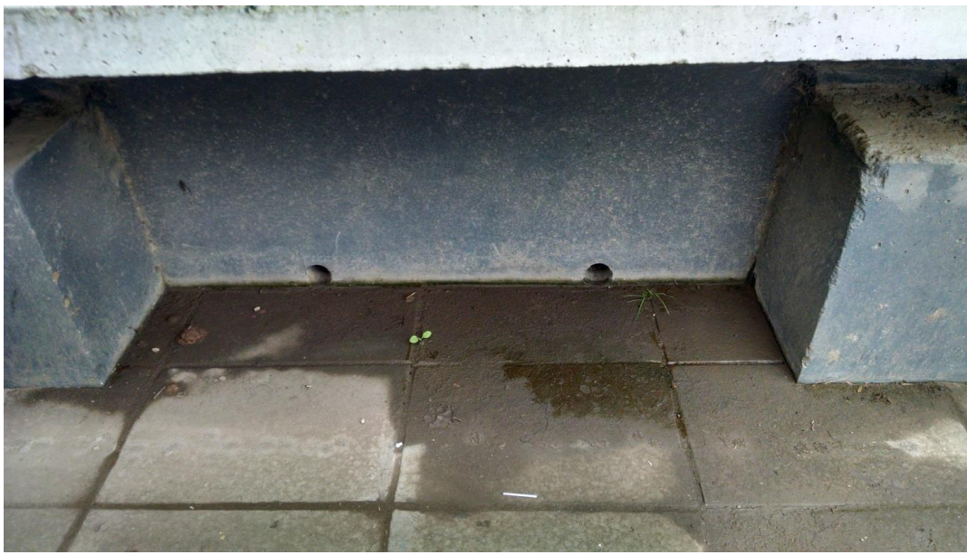
Módulos donde se deben realizar las aberturas
