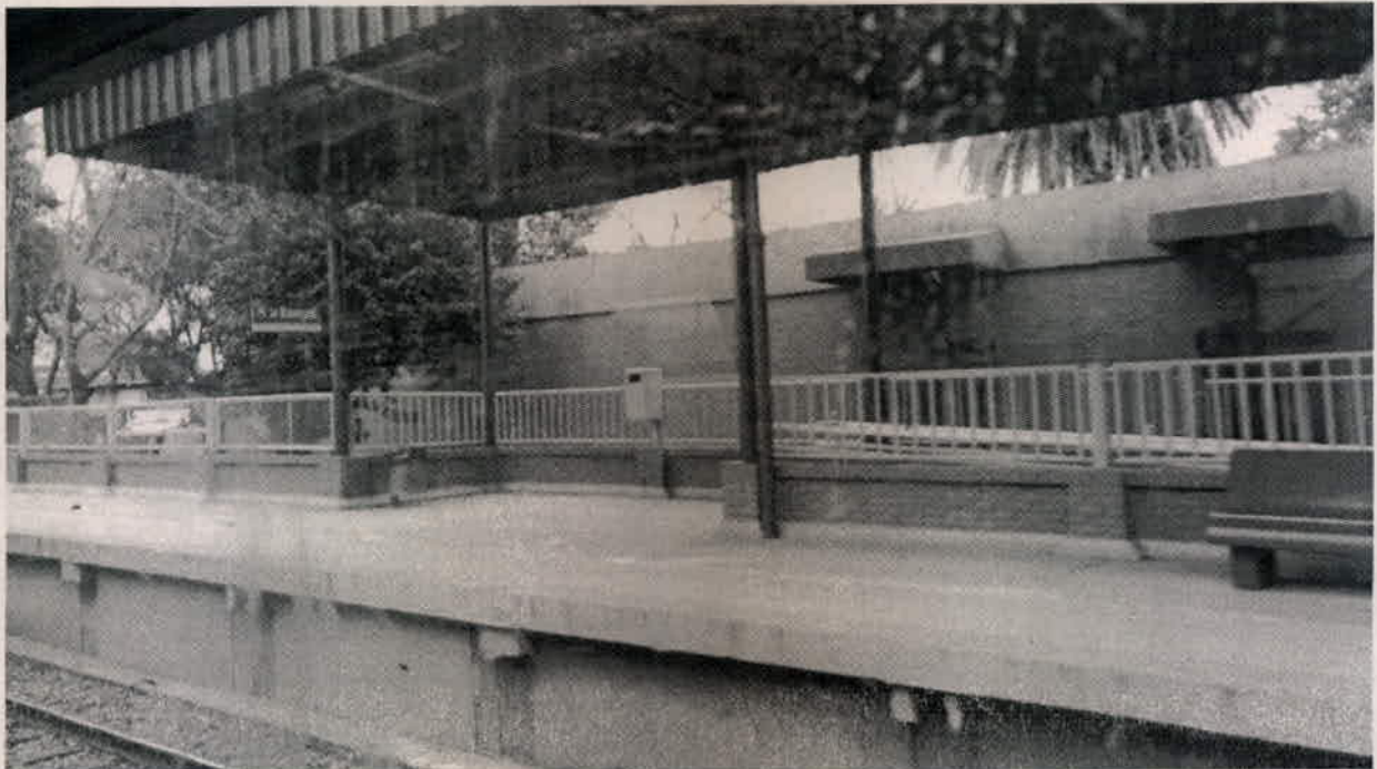
Exterior sala de relé
