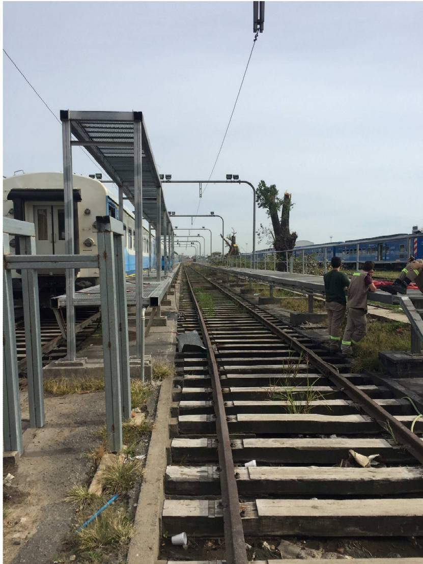
PLATAFORMAS 2 Y 3 – LADO RETIRO
