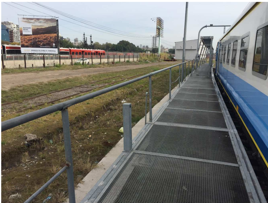
PLATAFORMA 1 – BARANDAS DE SEGURIDAD
