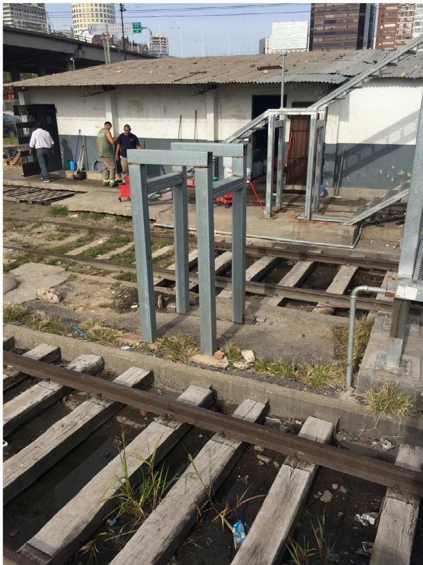
LADO RETIRO – SECTOR ESCALERAS
