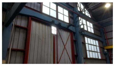
Carpinterías a ejecutar puesta en valor y recambio de vidrios por paneles de policarbonato, para su posterior colocación de rejas anti vandálicas tipo shulman según PETP, Sector frente del taller lado interior del mismo, zona de acceso de formaciones.
