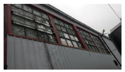
Carpinterías a ejecutar puesta en valor y recambio de vidrios por paneles de policarbonato, para su posterior colocación de rejas anti vandálicas tipo shulman según PETP, Sector lateral del taller.
