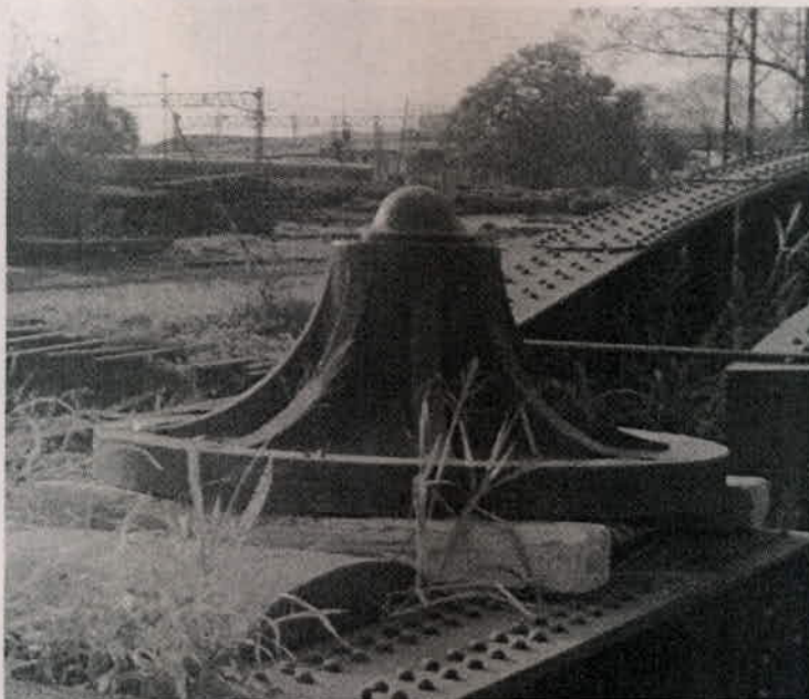
Fotografía 5 Base pivote de otra mesa. Notar que le falta el rodamiento que va colocado sobre el anillo centrado con la semiesfera.
