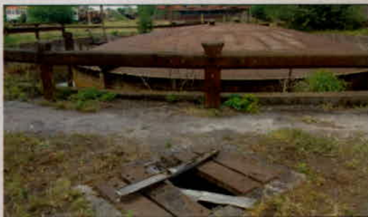
Foto 5 – Cámara de desagüe.
