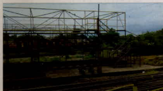
Foto 10 – Lavadero de Locomotoras.
