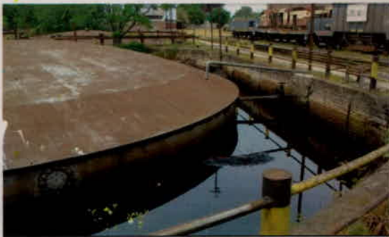
Foto 3 – Ubicación de tanque área de almacenaje de combustible (Fuera de servicio).
