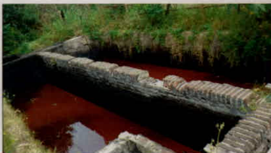
Foto 7 – Cámara de desagüe.
