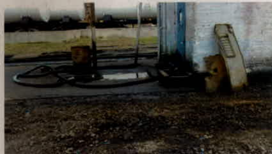
Foto 6 – Cámara de desagüe.
