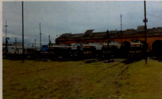
Foto 4 – Surtidor de gasoil, utilizado actualmente para la carga de combustible.
