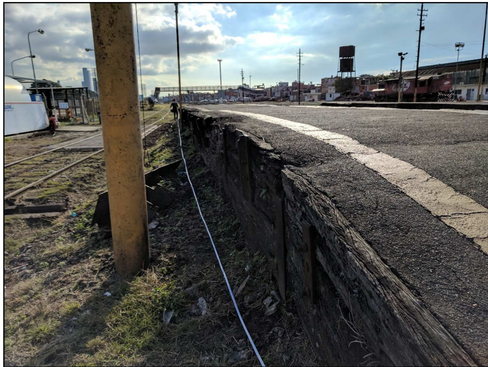
ANEXO FOTOGRÁFICO – Construcción de muro cortafuegos en playa de carga de combustibles a furgones de Retiro – L.S.M.
