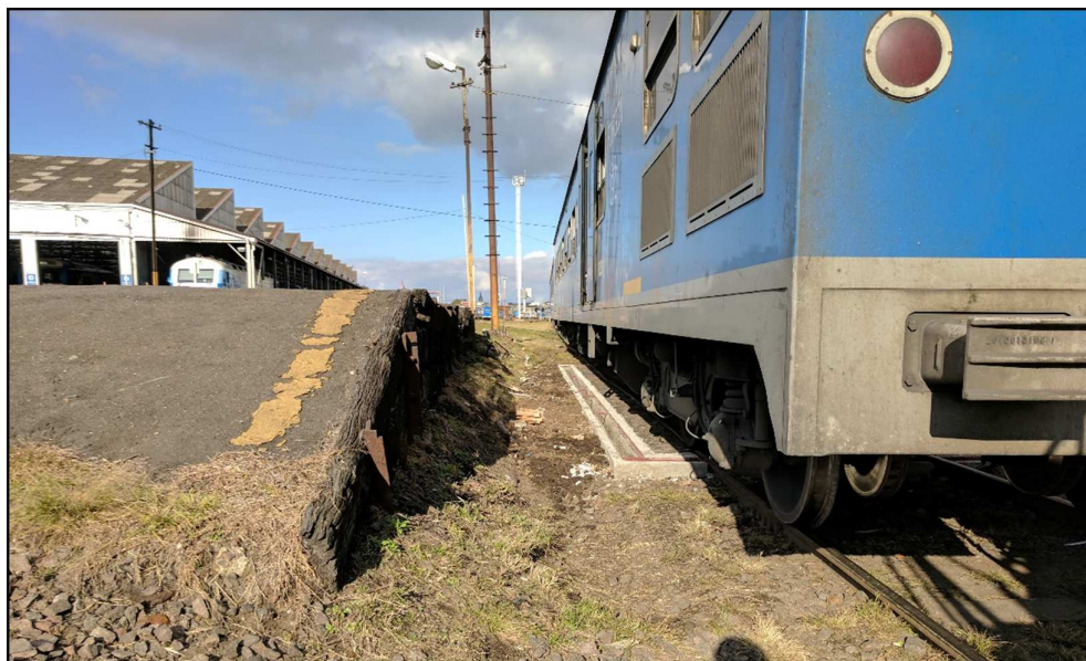
ANEXO FOTográfico – Construcción de muro cortafuegos en playa de carga de combustibles a furgones de Retiro – L.S.M.
