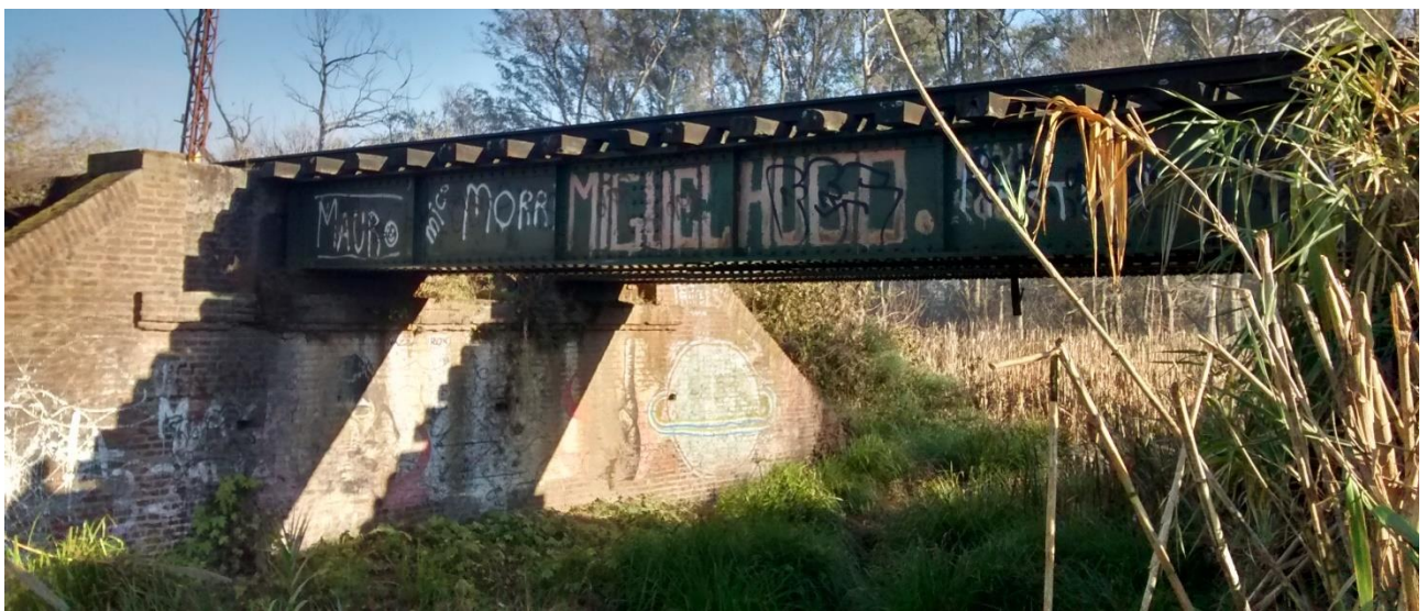
Vista global del Puente
