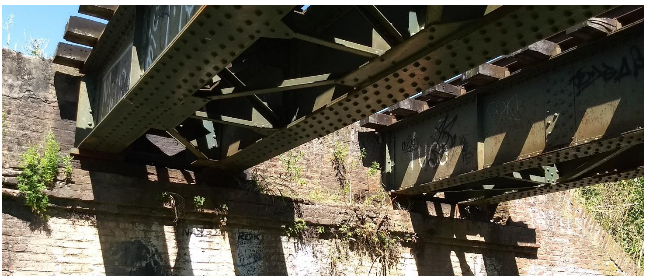
Zona de apoyos
