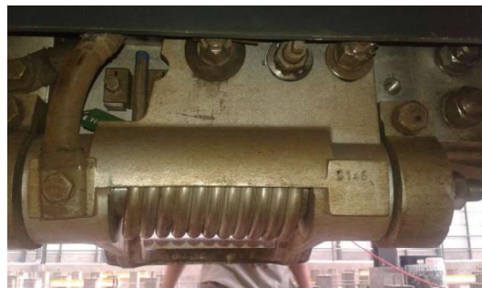
Imagen trasera inferior – Última inspección
