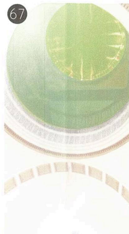
67 Puesta en valor de cúpula. Limpieza y reparación en caso de ser necesario. Reparación y restauración de cielorraso existente, revoques y molduras. Pintura en cielorraso y tabiques. Restauración de barandas.
