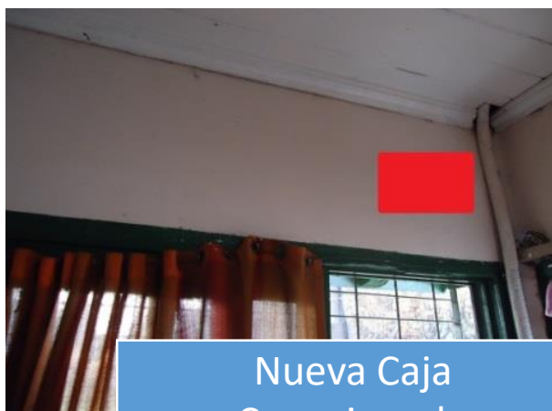
Canalización existente
