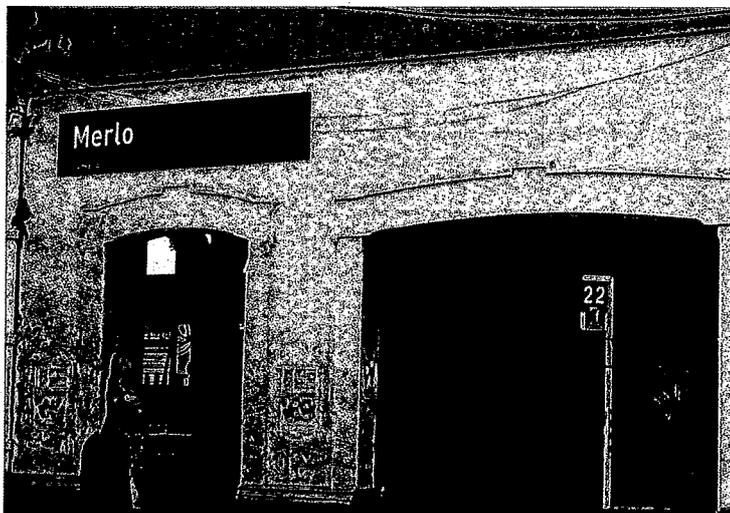
**Descripción:** Esta señal en particular se logra a partir de una bandeja de chapa de hierro (Fe), anclado a la pared mediante un bastidor o marco de sujeción. La misma lleva el nombre de cada estación y va colocada a gran altura permitiendo su lectura desde una distancia considerablemente lejos.
