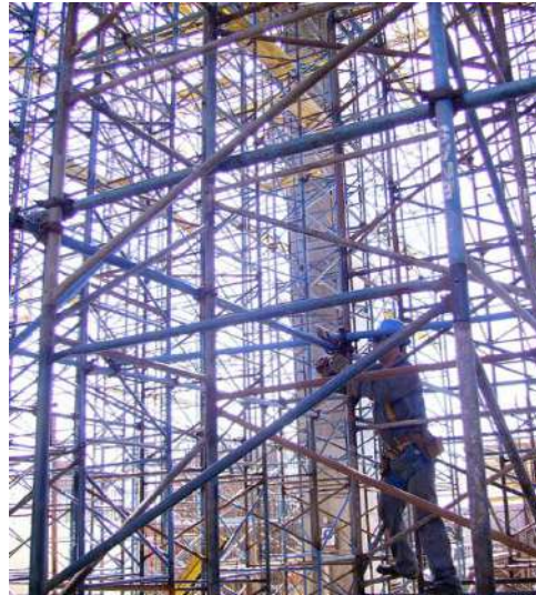
Apuntalamiento tipo Caño y Nudo.
