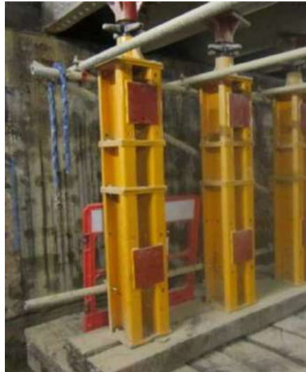
Apuntalamiento tipo Estructura Metálica.
