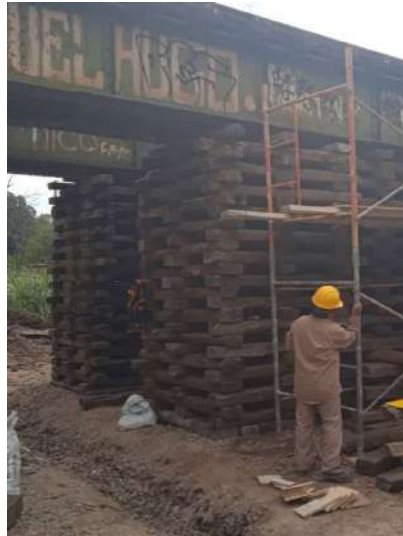
Apuntalamiento tipo Pilastra.
