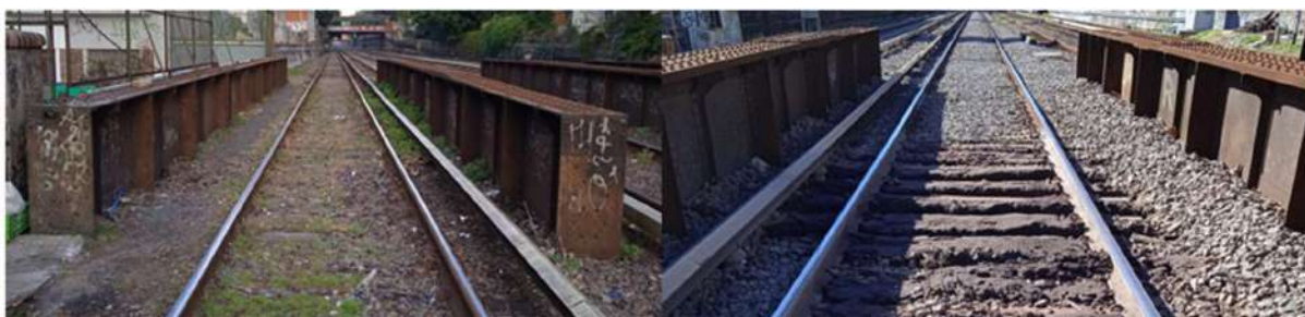
Imagen18: OA 2.082 - Tierra sobre VL1 y Balasto colmatado sobre VG1
