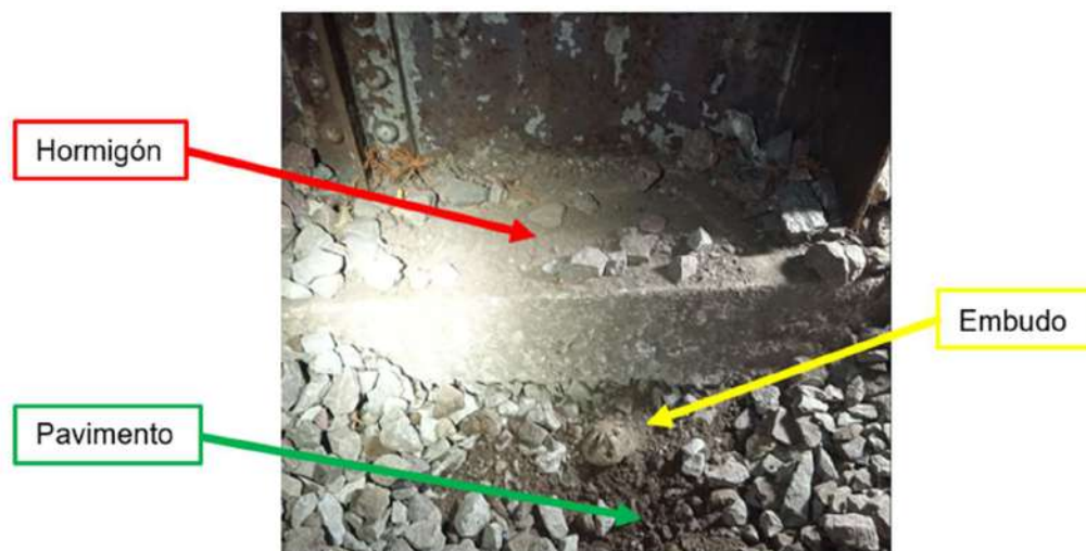
Imagen 19: Hormigón y pavimento sobre tableros y en zona de desagües.
