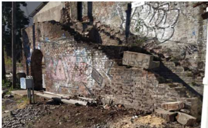
Imagen 20: Mampostería a demoler – Lado Sur
