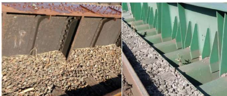
Imagen 23: Puente sin guardabalasto VS puente con guardabalasto
