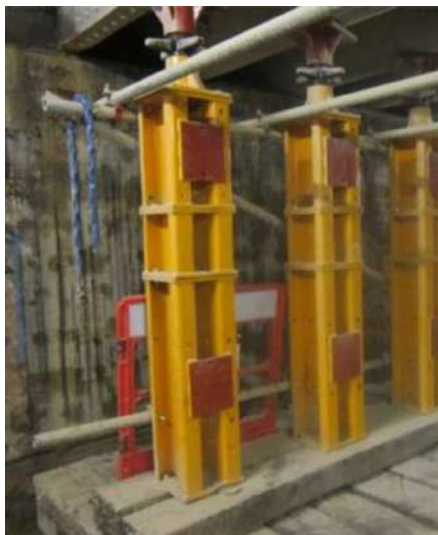
Apuntalamiento tipo Estructura Metálica.
