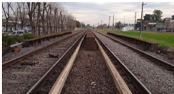
Imagen 25: Riel conductor en OA 32.121
