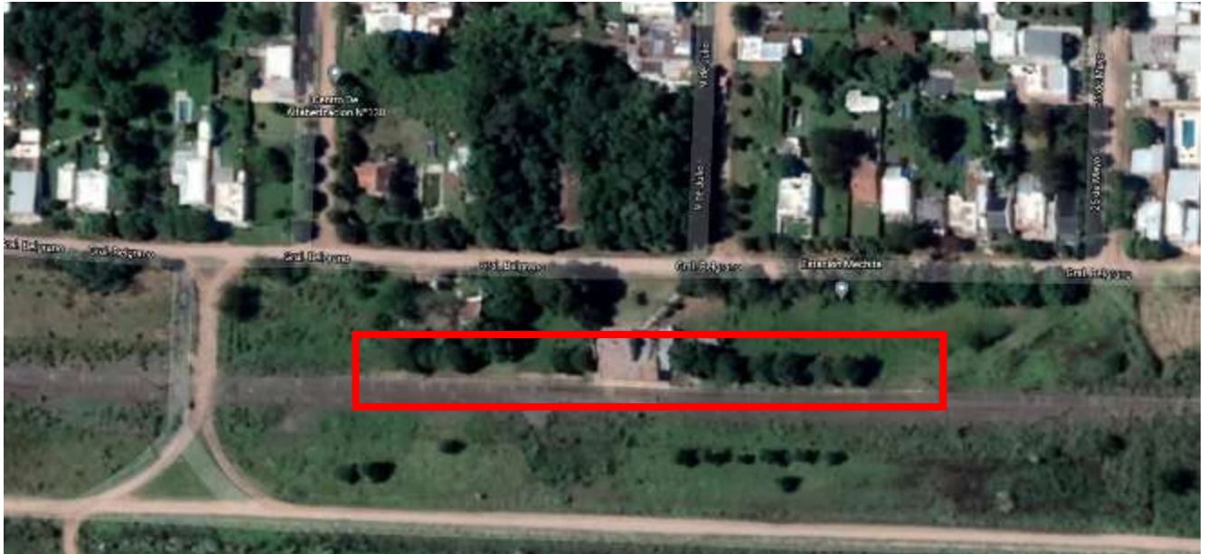
Imagen 3: Vista área de la Estación Mechita.
